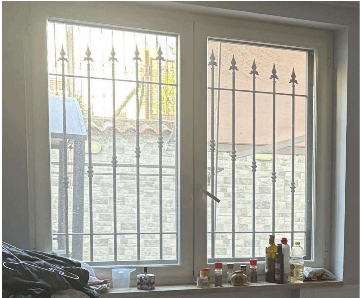
Foto n. 24: • Tipologia infissi esterni.
