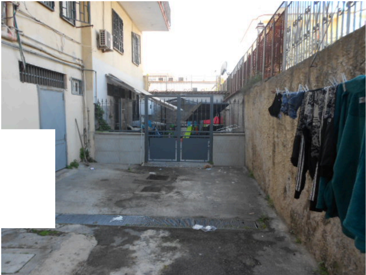
Foto n. 8: • Muretto con inferriata che delimita abusivamente la parte terminale del viale ad uso comune.
