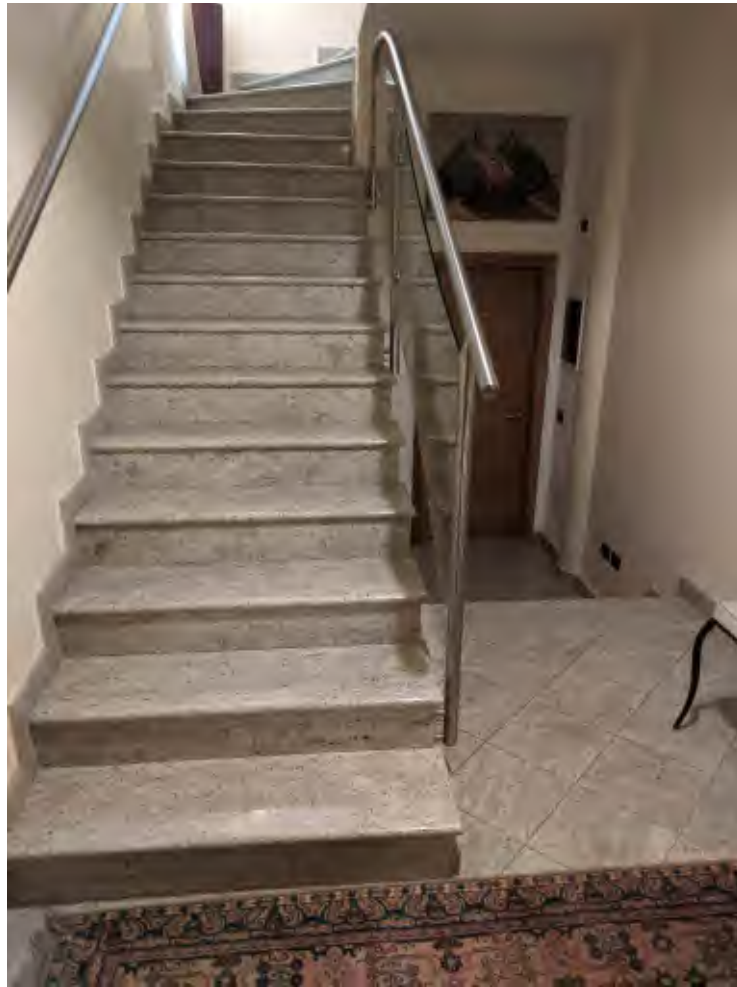
Foto n° 43: Zona residenziale, piano terra: vano scale.
