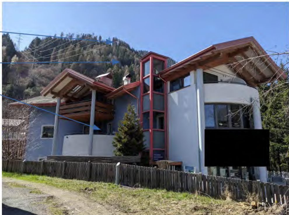
Foto n° 40 Vista fronte sud-est.
