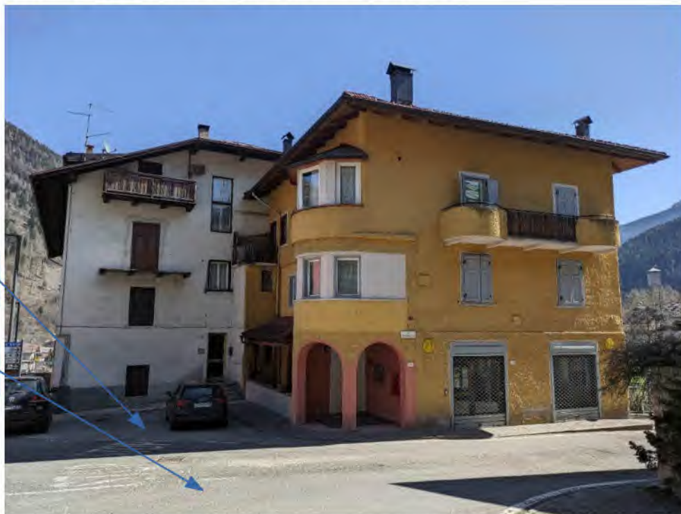
Foto n° 2: Vista fronte sud-ovest (porzione giallo/ocra).
