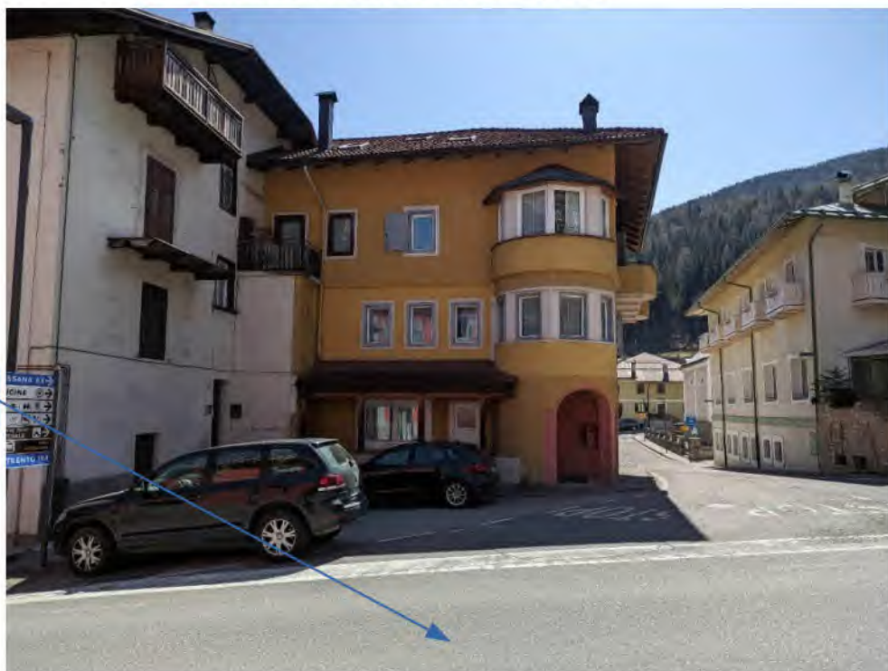
Foto n° 3: Vista fronte nord-ovest (porzione giallo/ocra).
