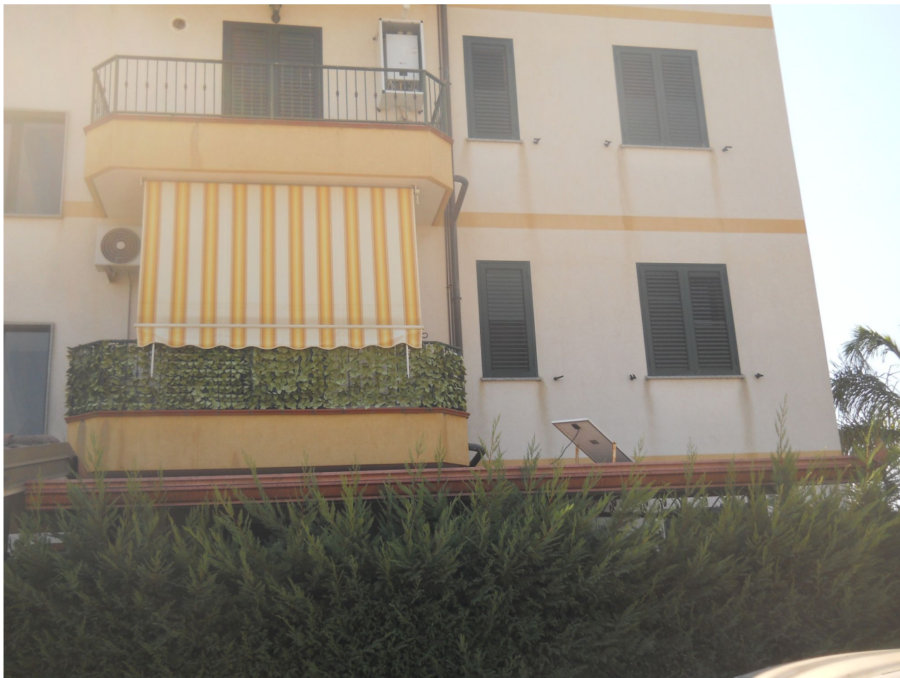
Foto n. 2 – Prospetto lato ingresso portone principale
