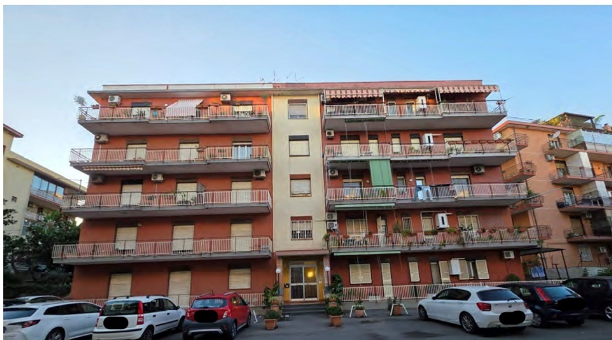
Foto 1: Lo stabile condominiale ove è sito l'appartamento pignorato
