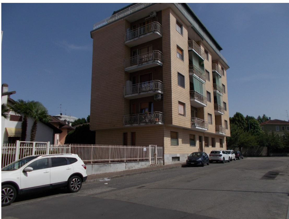
Foto 2. Condominio Don Sturzo – prospetto su Via Vercelli
