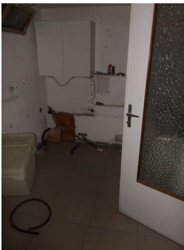
Foto 9. Ripostiglio - piano seminterrato
