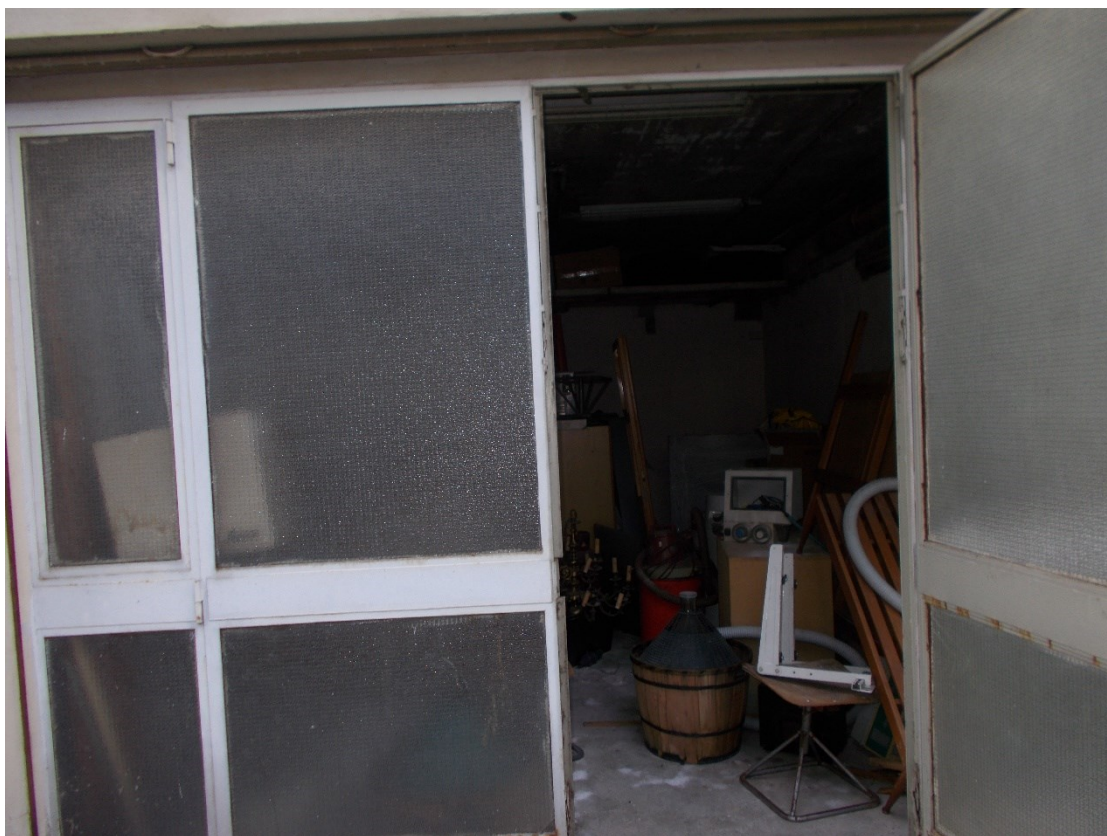
Foto 5. Particolare Accesso al magazzino - piano seminterrato
