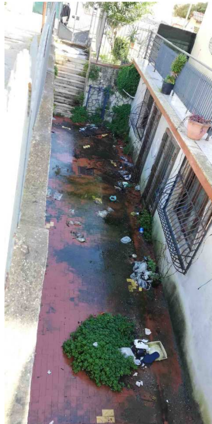
Vista dell'ingresso all'immobile
