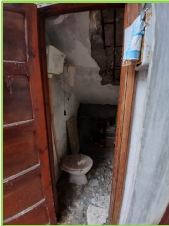
Ripostiglio – Sottoscala piano terra
