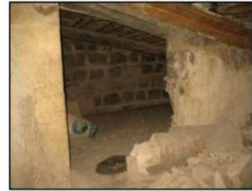
Sottotetto al terzo piano
