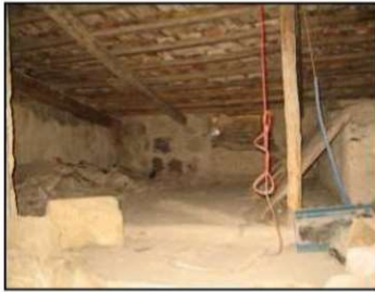
Sottotetto al terzo piano
