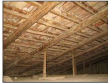
Sottotetto al terzo piano
