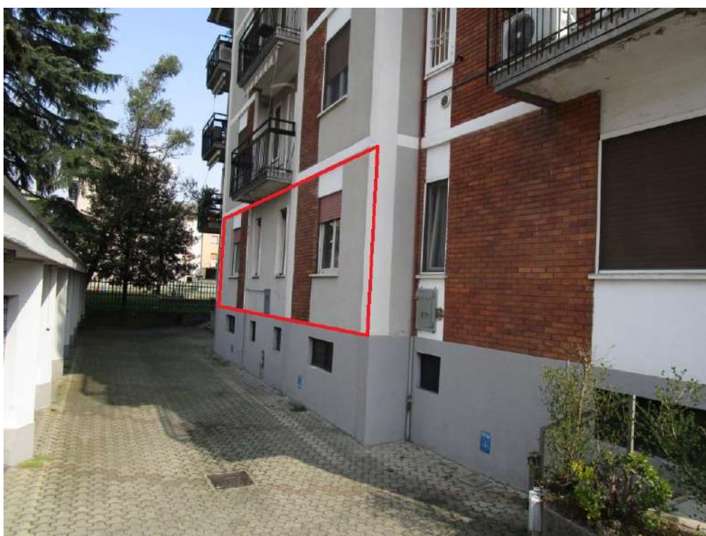
Foto 2 – Vista e inquadramento dell’unità immobiliare
