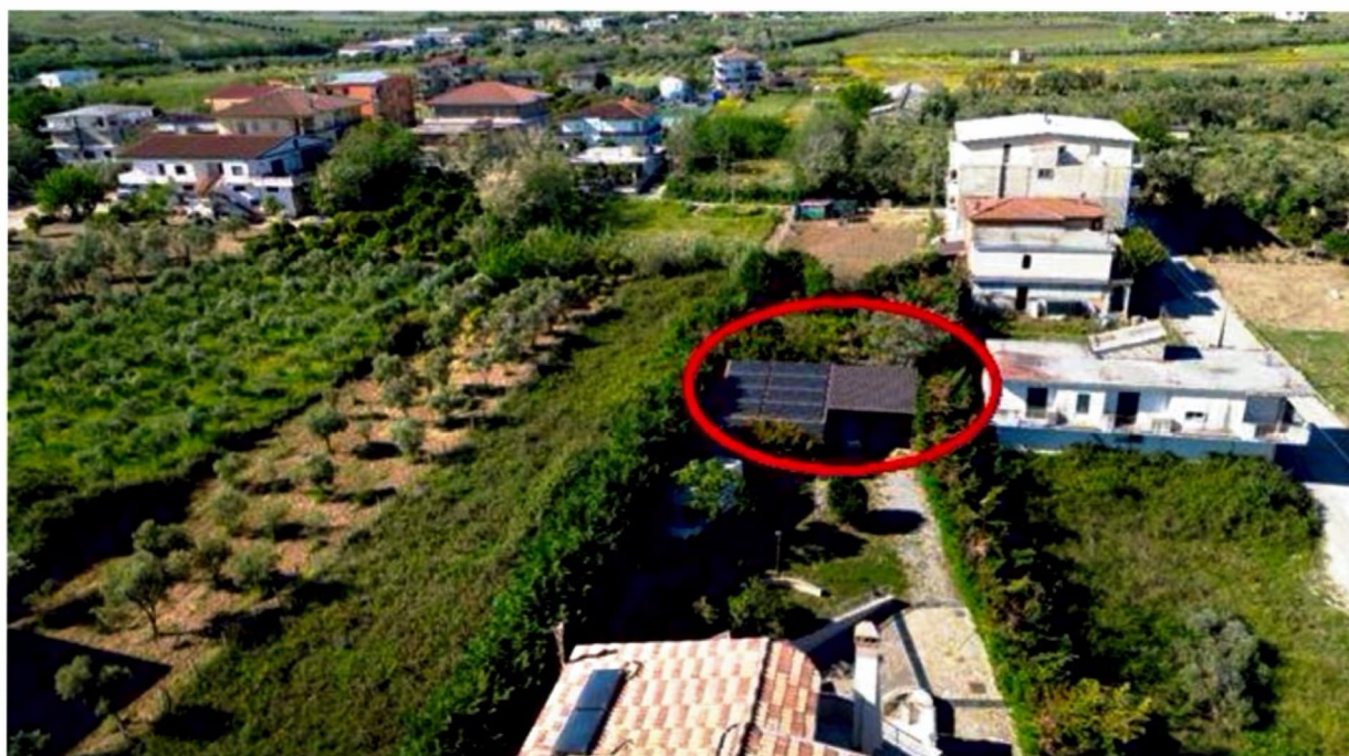
Locale esterno da considerarsi abusivo
