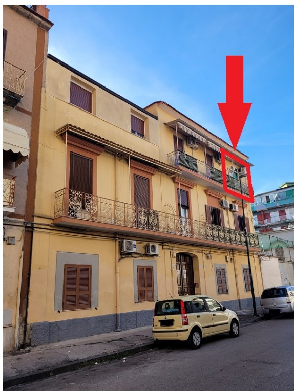
Vista Via Cardinale Filomarino immobile di cui al sub 13
