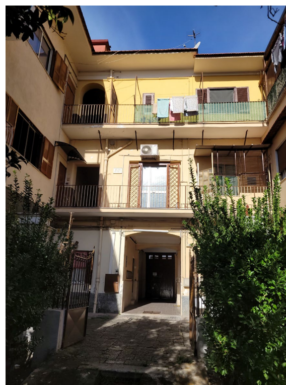
Vista prospetto interno dello stabile
