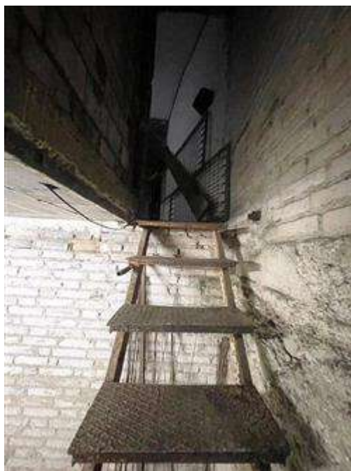
Scala di accesso al locale interrato
