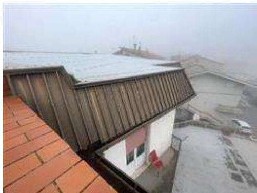
manto di copertura lastrico solare
