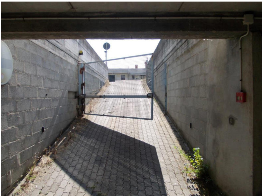
Foto 2 Particolare rampa 1 accesso box
