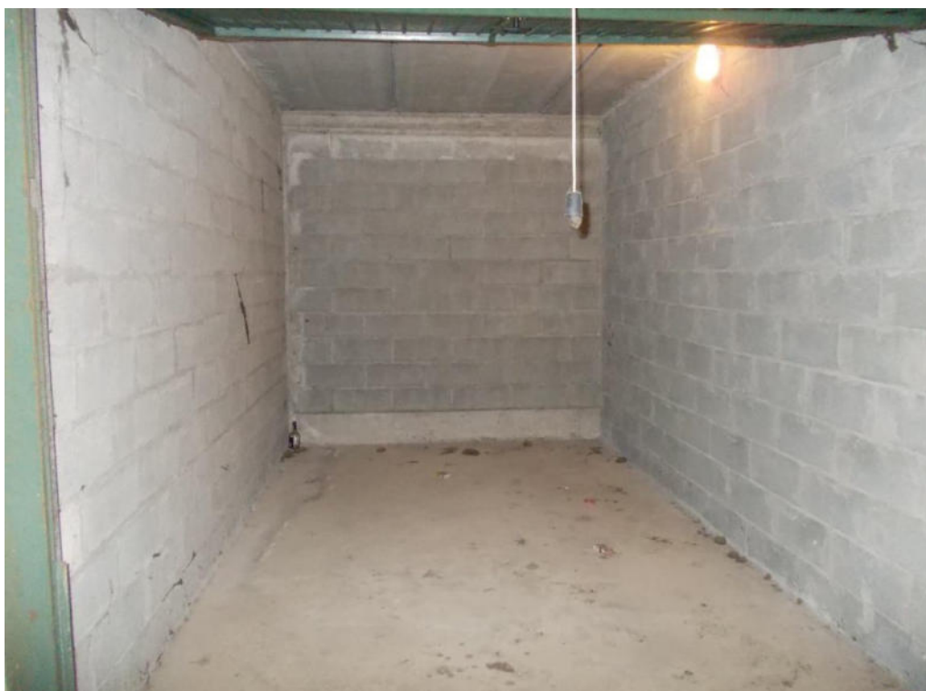
Foto 6 Particolare interno box tipo
