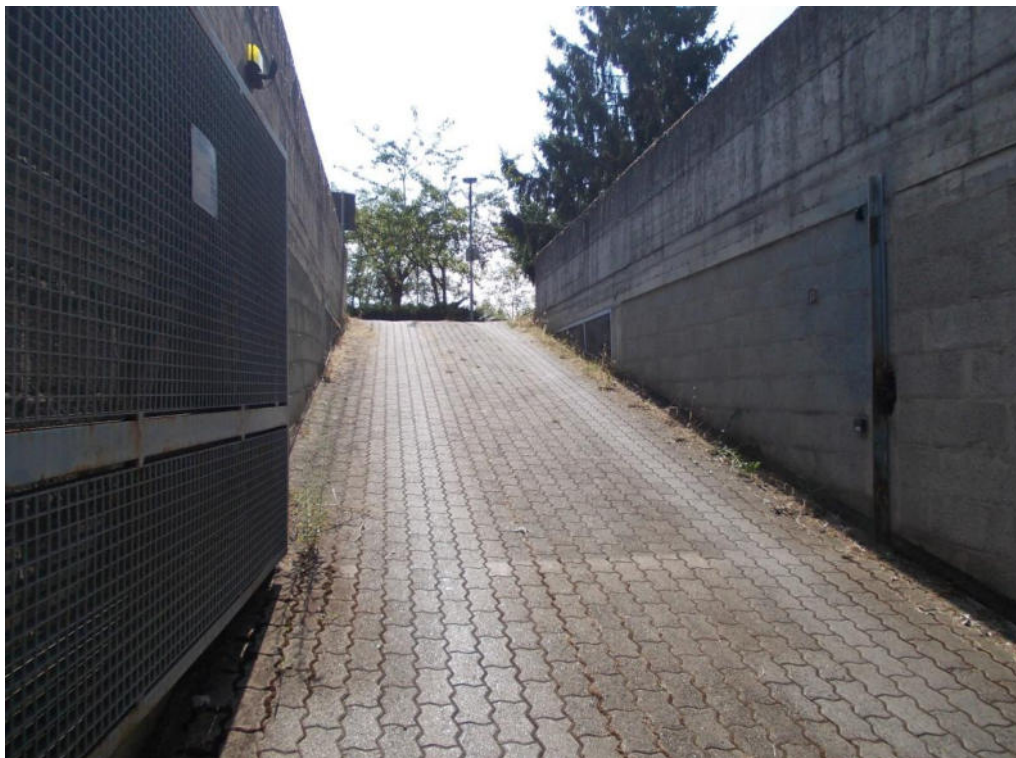
Foto 3 Particolare rampa 2 accesso box
