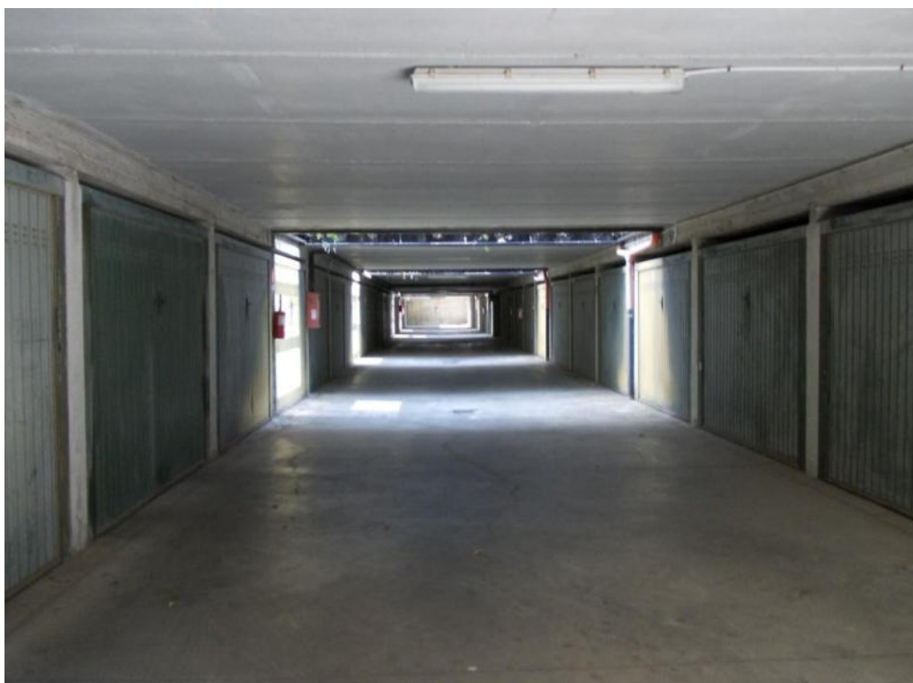
Foto 4 Corridoio di manovra comune
