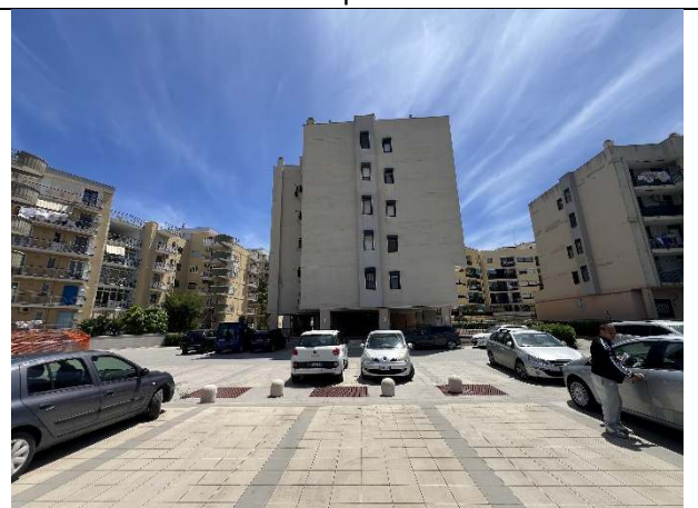
Foto n. 6 – Prospetto dal Parcheggio esterno
