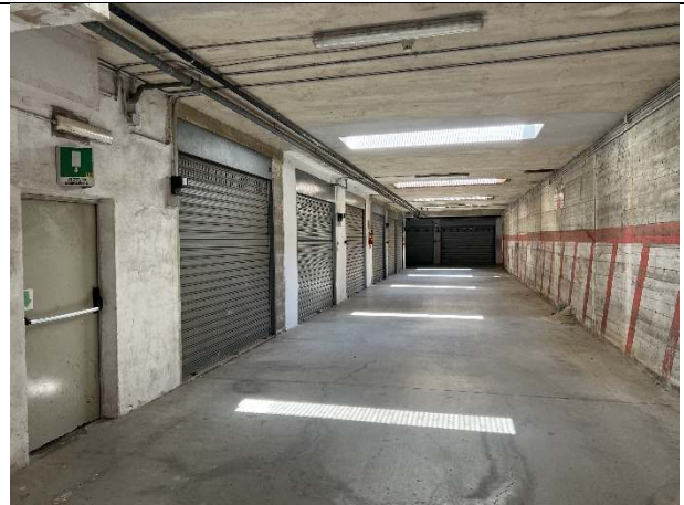
Foto n. 39 – Corsia di Manovra
