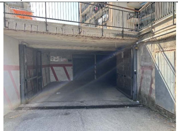
Foto n. 33 – Ingresso corsia di manovra
