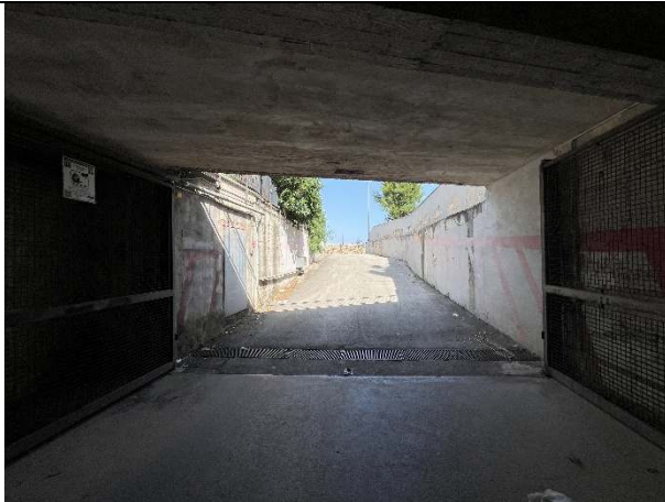
Foto n. 34 – Ingresso corsia di manovra
