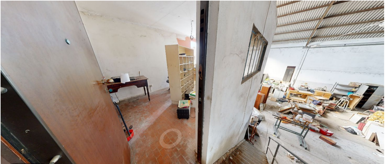
23. Vista dell'interno del fabbricato (loca 8).
