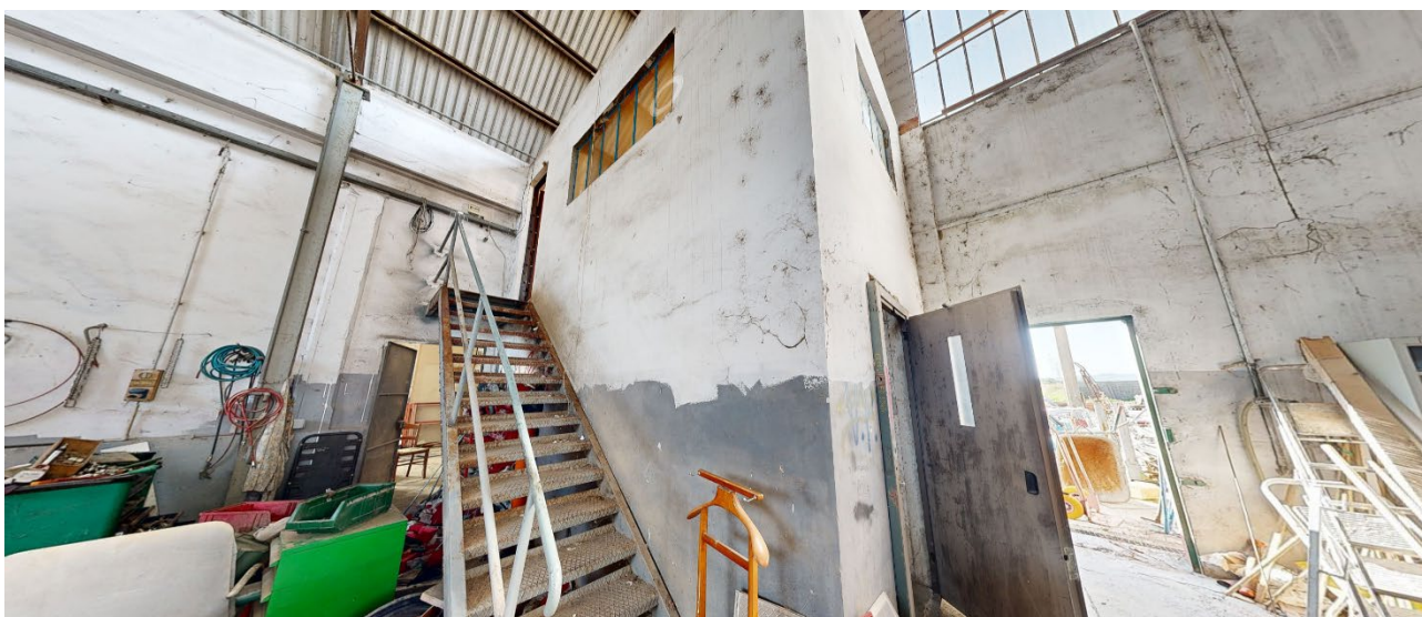
22. Vista dell'interno del fabbricato (locale 3).
