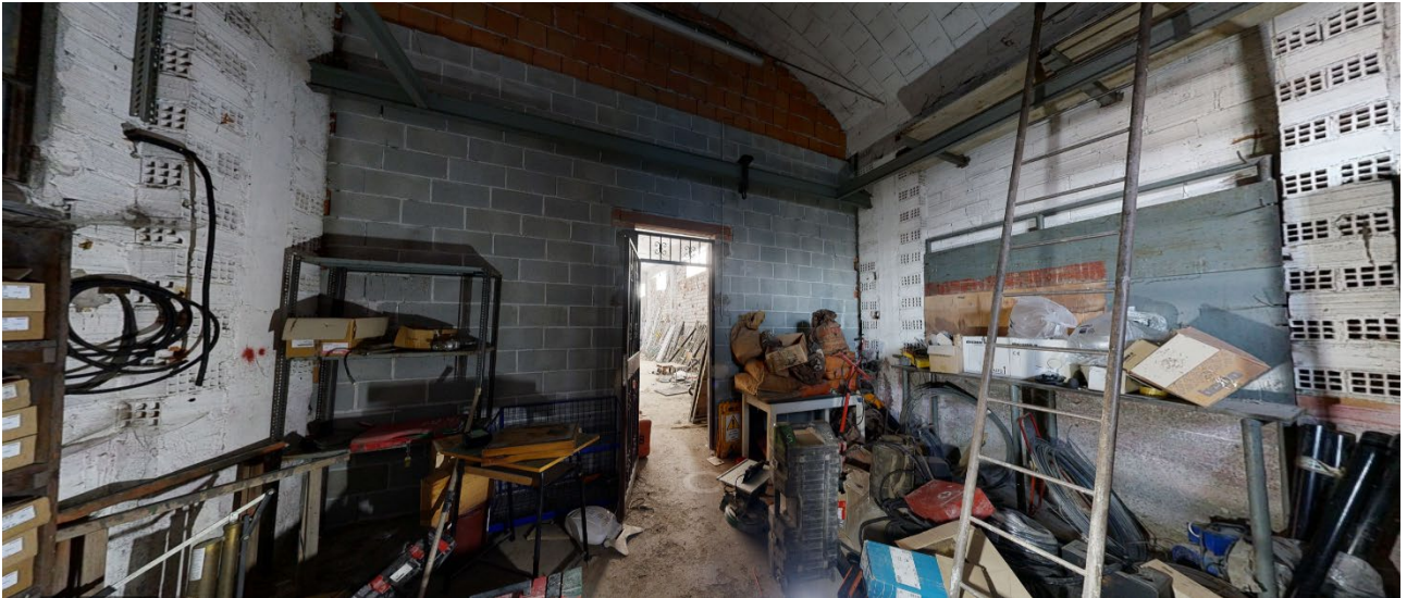
17. Vista dell'interno del fabbricato (loca 5).
