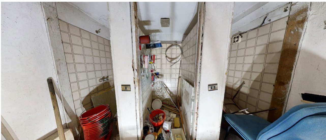
20. Vista dell'interno del fabbricato (wc).
