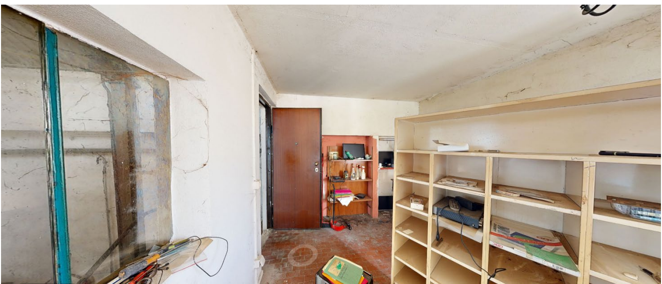
25. Vista dell'interno del fabbricato (loca 8).
