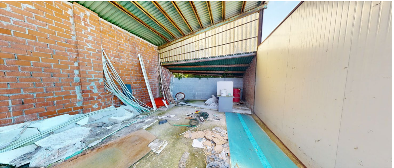
30. Vista dell'interno del fabbricato (tettoia 4).
