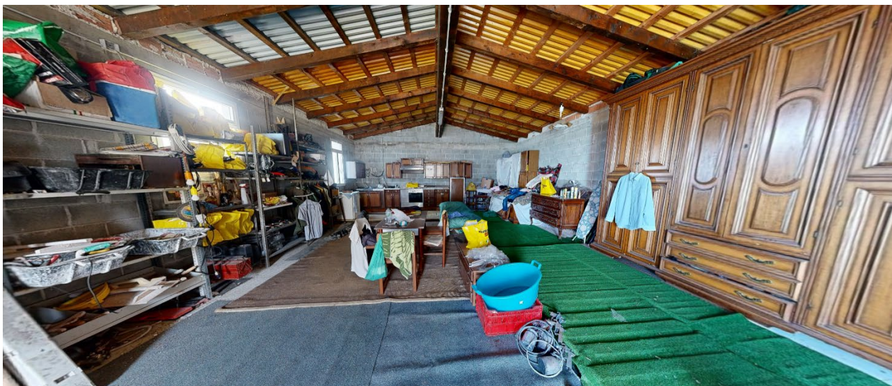
26. Vista dell'interno del fabbricato (loca 7).
