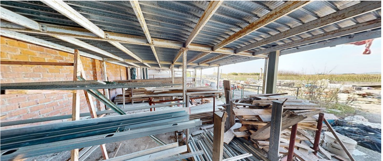
29. Vista dell'interno del fabbricato (tettoia 3).
