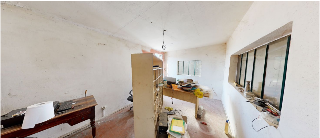
24. Vista dell'interno del fabbricato (loca 8).
