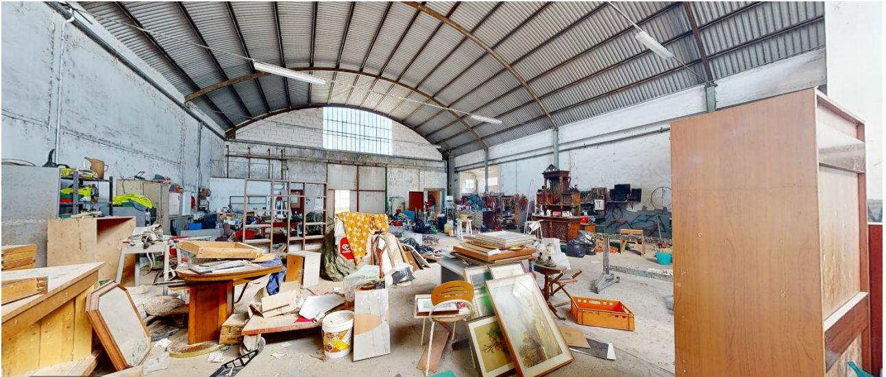
11. Vista dell'interno del fabbricato (locale 1).
