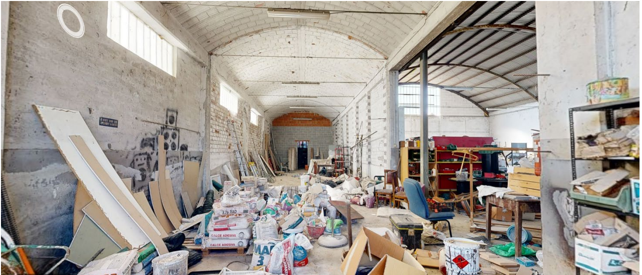
14. Vista dell'interno del fabbricato (locale 4).
