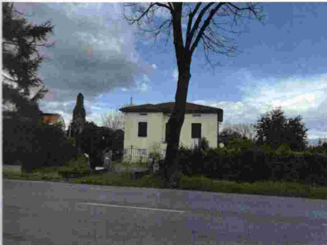
Descrizione: Esterno - Vista da Via Sarzanese
