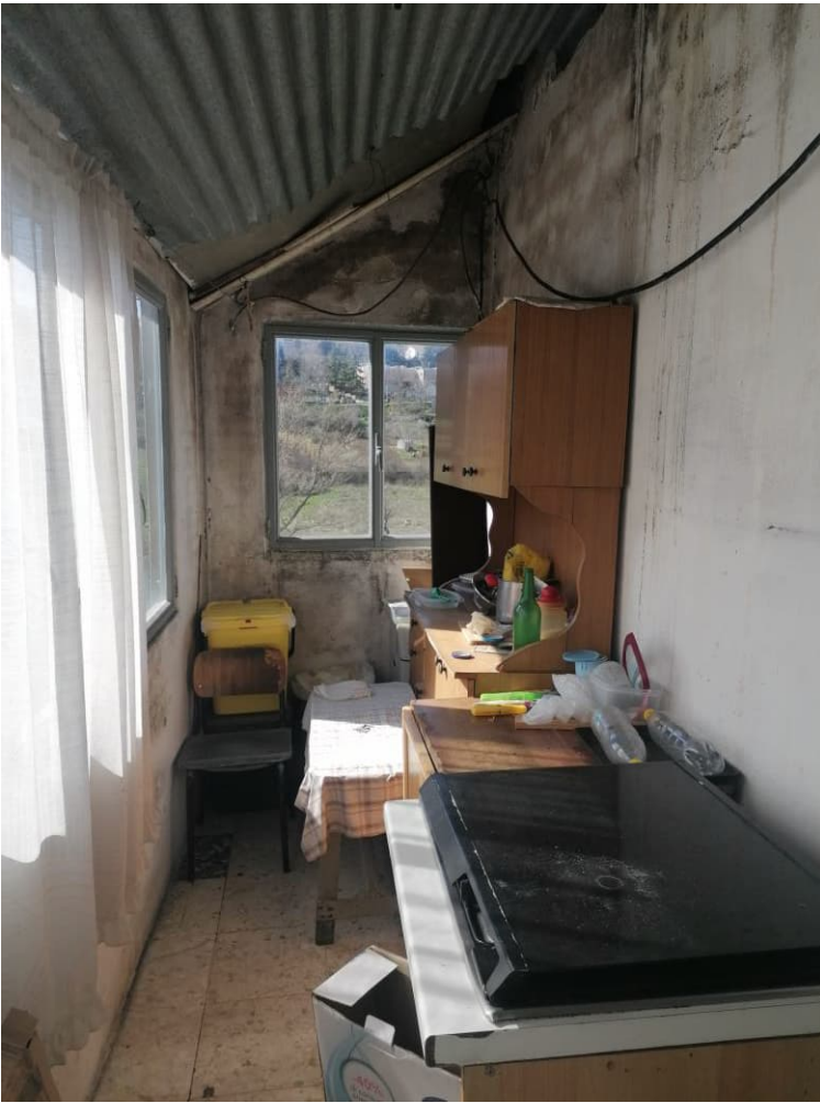
Balcone chiuso via delle Matine
