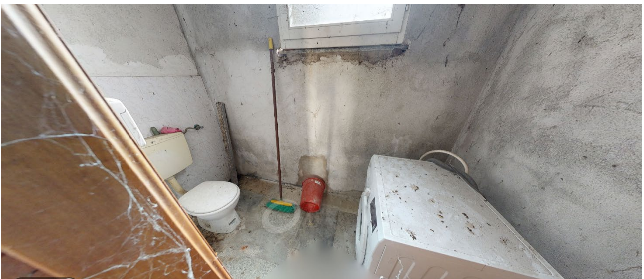
38. Vista dell'interno del fabbricato (locale sgombero 2).
