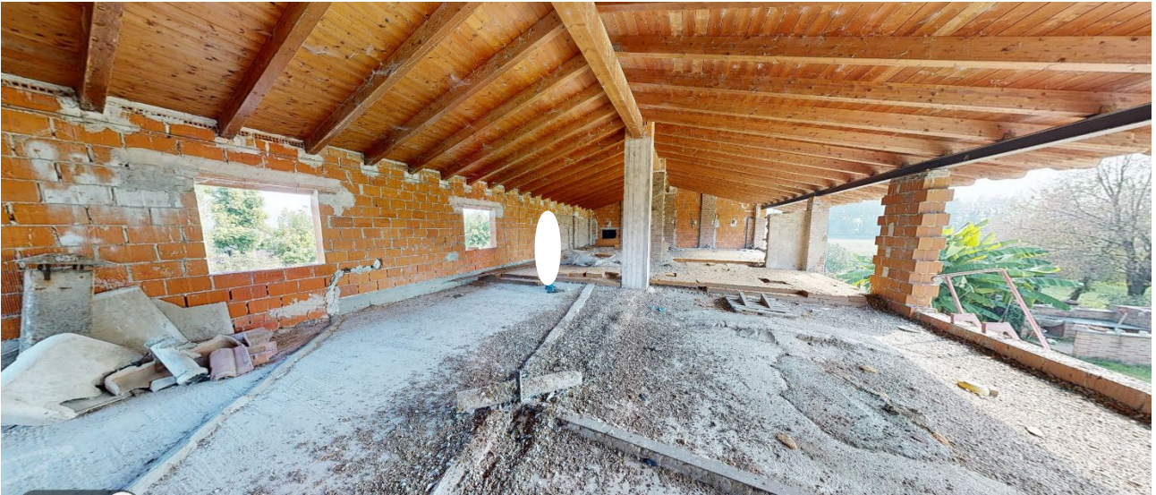
41. Vista generale locale sottotetto.
