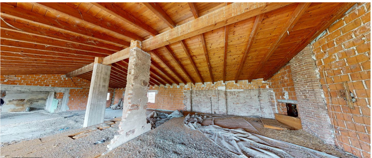
43. Vista generale locale sottotetto.
