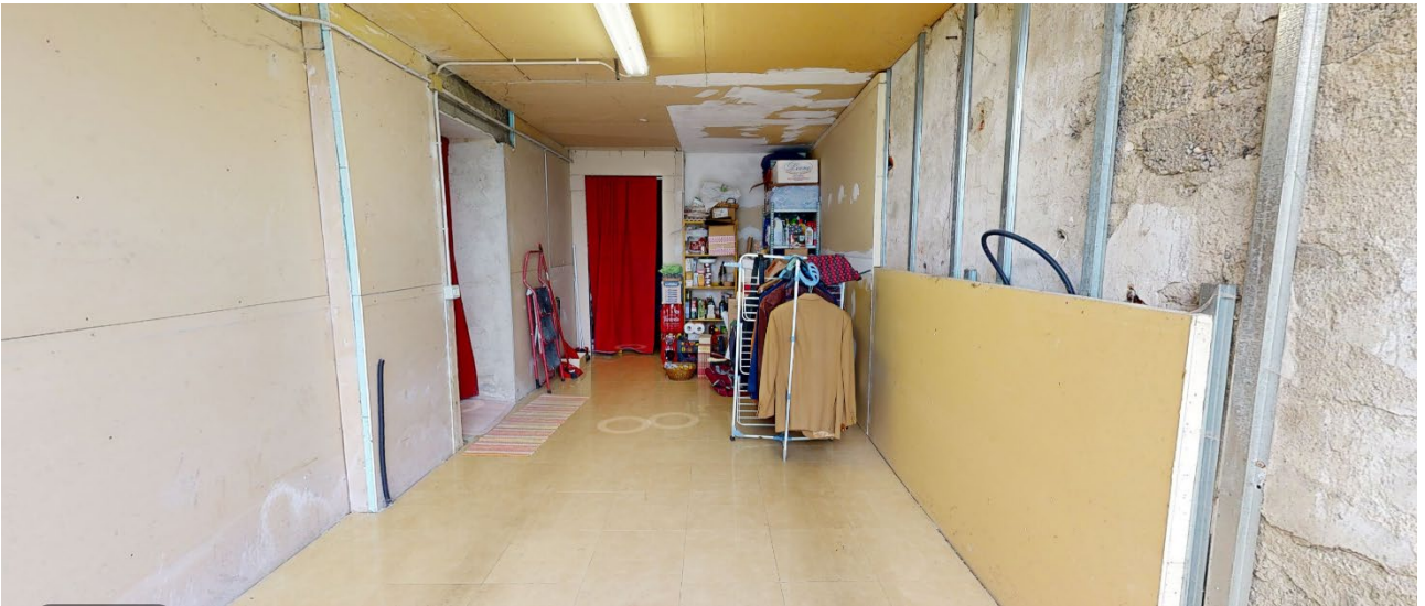
31. Vista dell'interno del fabbricato (garage).
