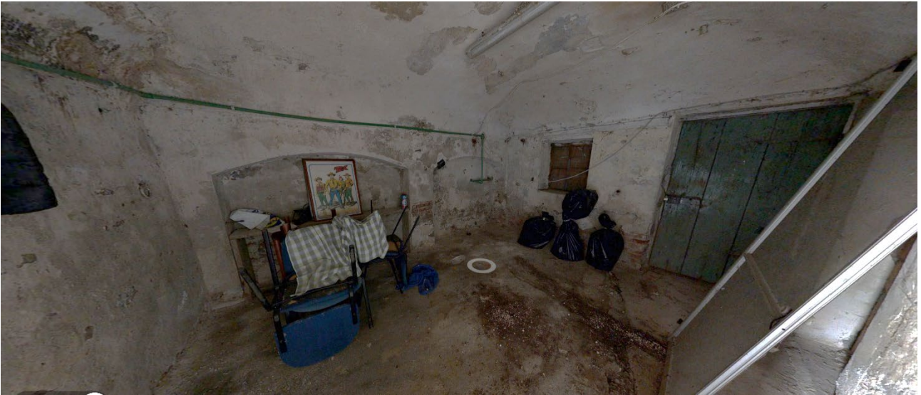
39. Vista dell'interno del fabbricato (locale sgombero 3).
