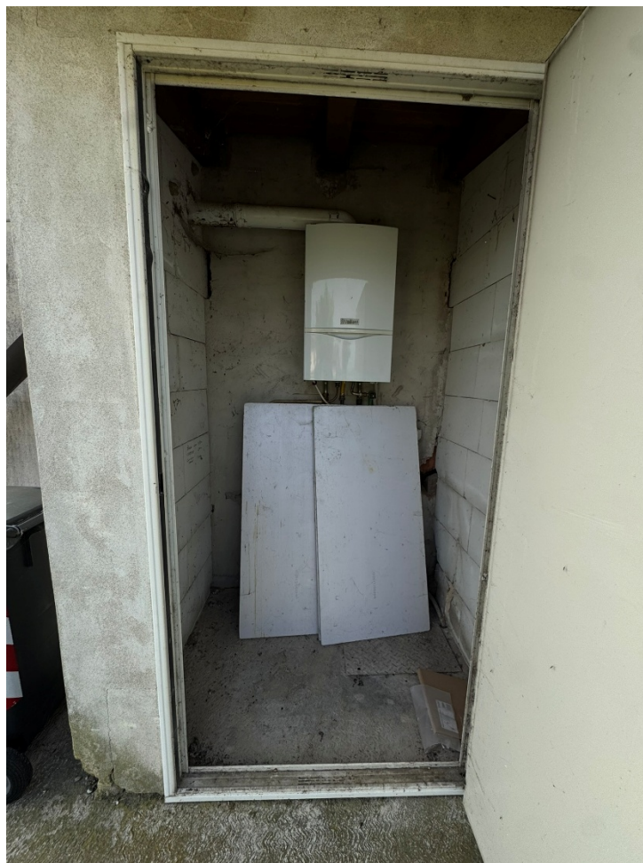
40. Vista dell'interno del fabbricato (centrale termica).
