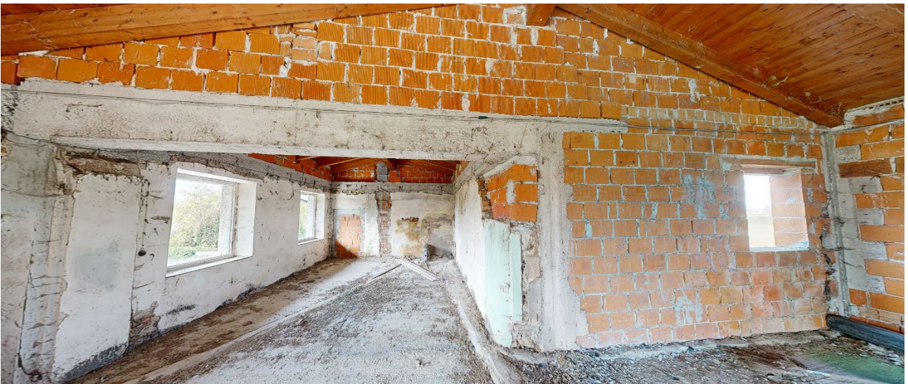
42. Vista generale locale sottotetto.
