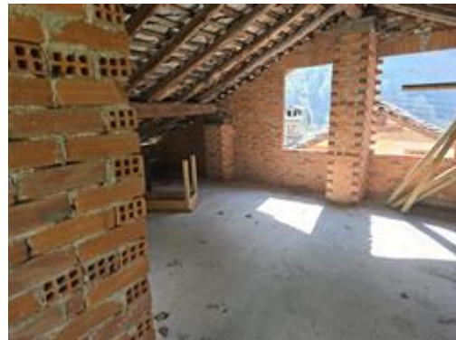
Deposito piano primo
