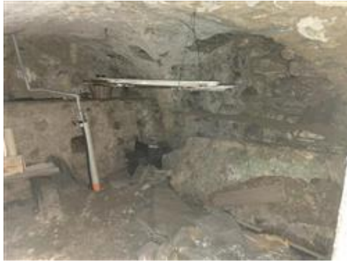
Cantina piano secondo seminterrato
