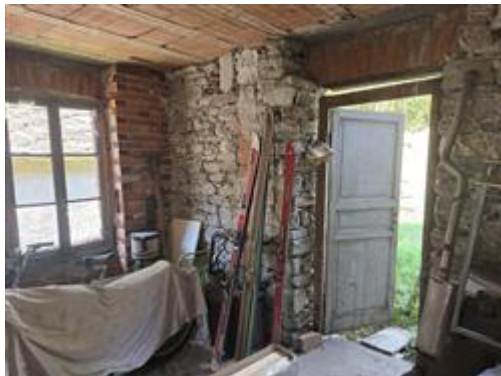
Deposito piano terra
