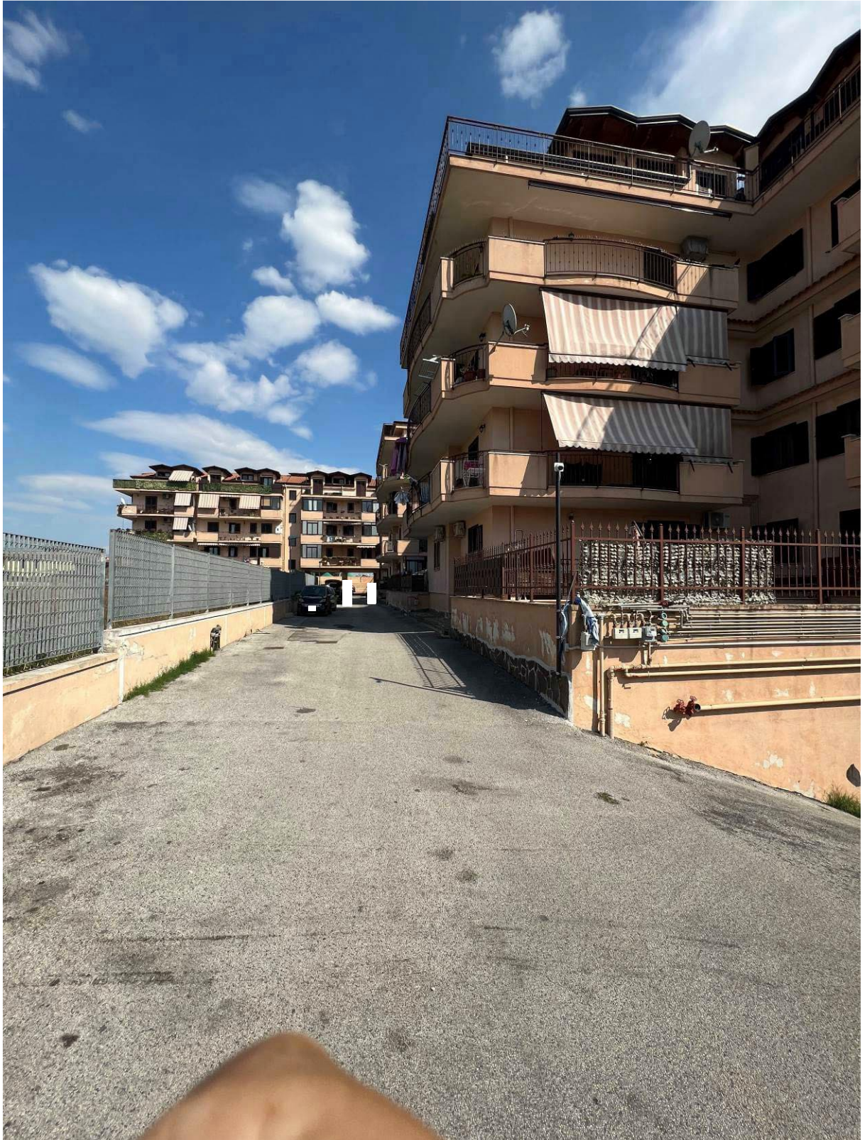
Foto Viale di accesso
