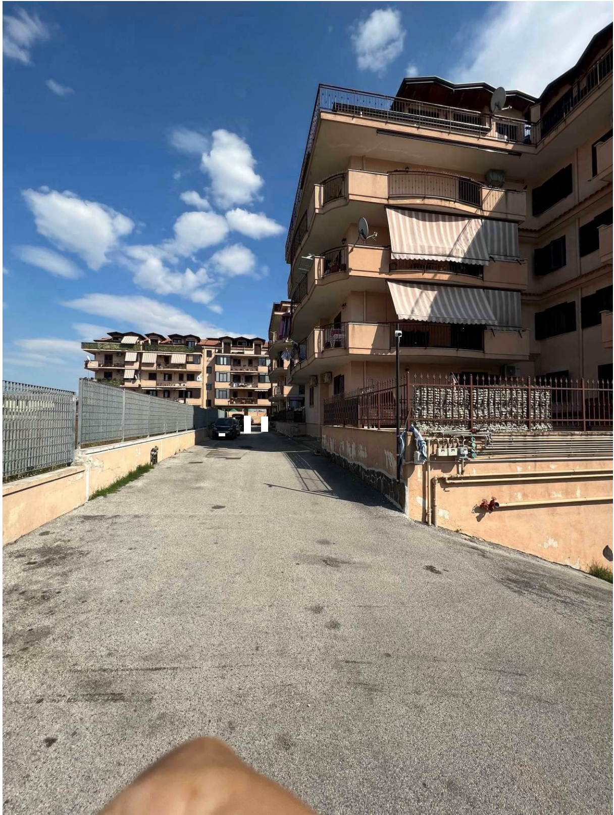
Foto Viale di accesso
