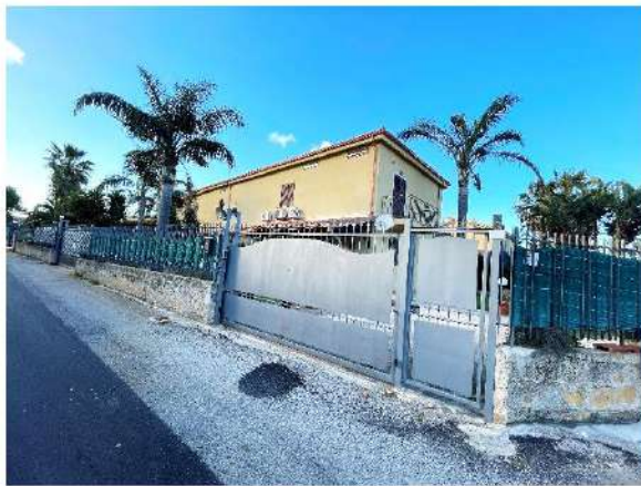
Ingresso carrabile e pedonale
