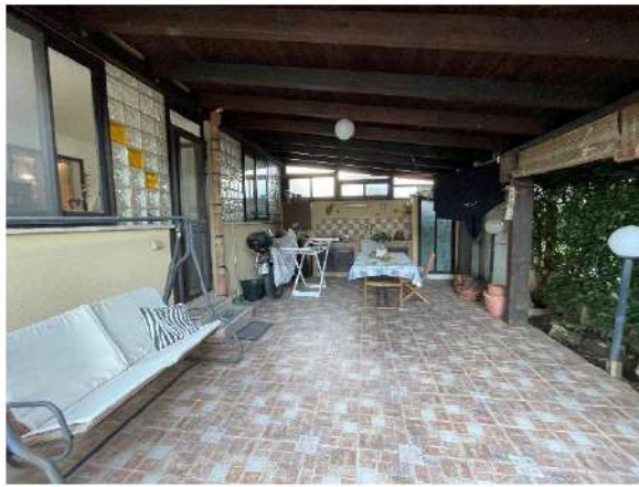
Piano terra – Pergolato/tettoia lato nord
