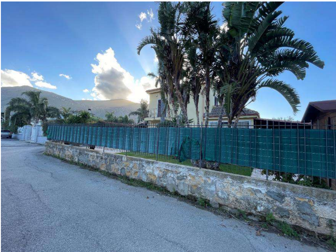
Foto n. 4 – Strada perimetrale lato est
