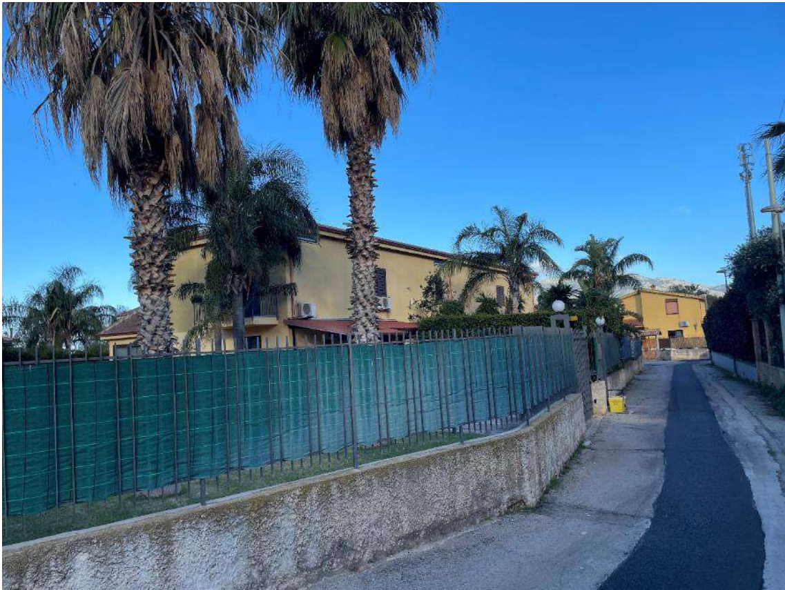
Foto n. 1 – Strada di accesso al lotto
