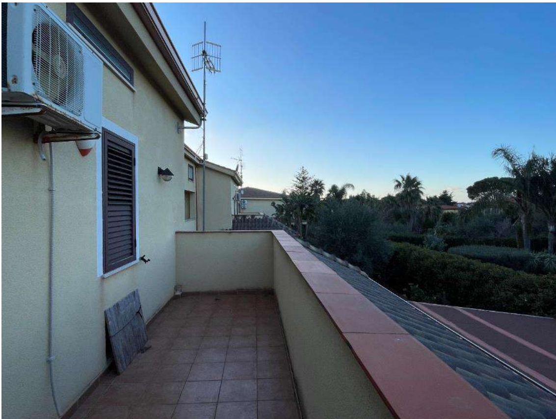
Foto n. 24 – 1°Piano: terrazzo prospetto nord
