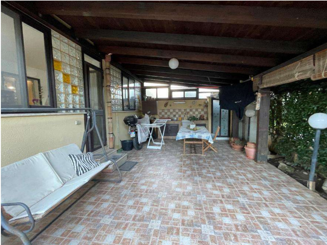
Foto n. 11 – Pergolato/tettoia fronte nord
