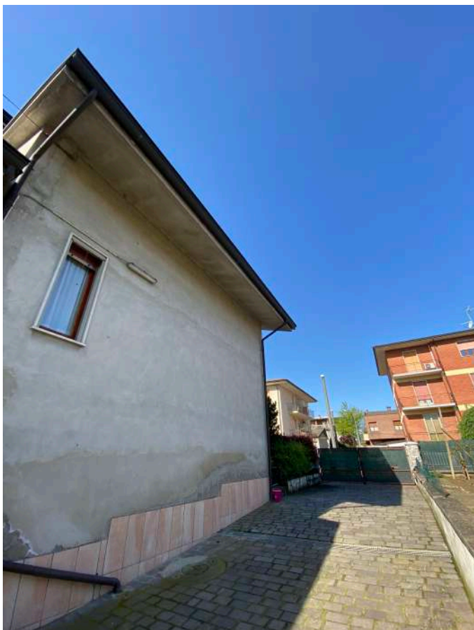
Foto 11: ingresso carraio da via Giotto
