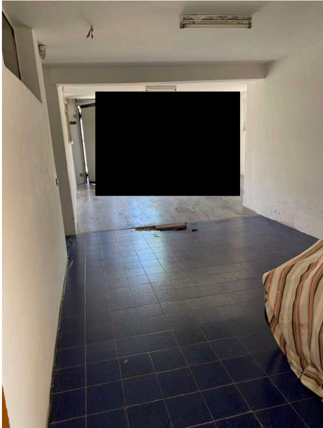
Foto 13: Autorimessa, vista interna
