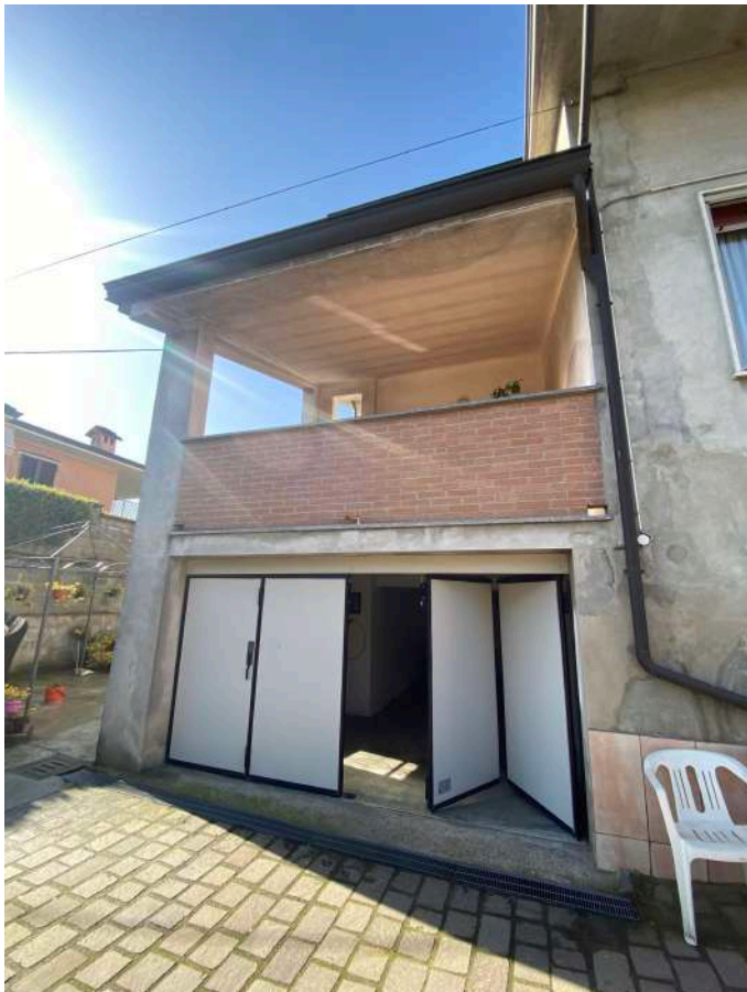
Foto 12: Ingresso esterno autorimessa – vista della terrazza dell'appartamento Corpo A
