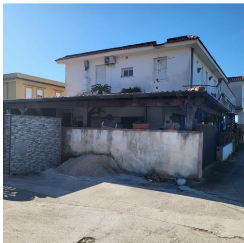
Veranda in struttura lignea
