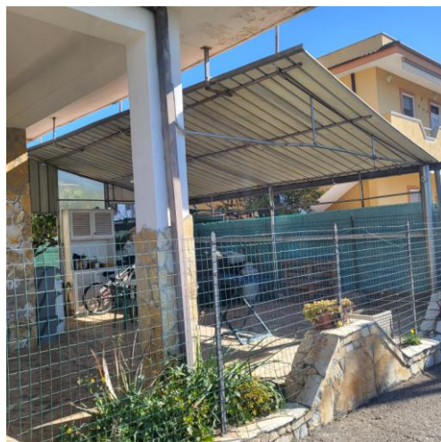
Tettoia in metallo
