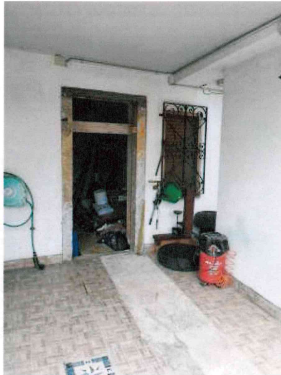
VISTA INGRESSO PIANO TERRA
