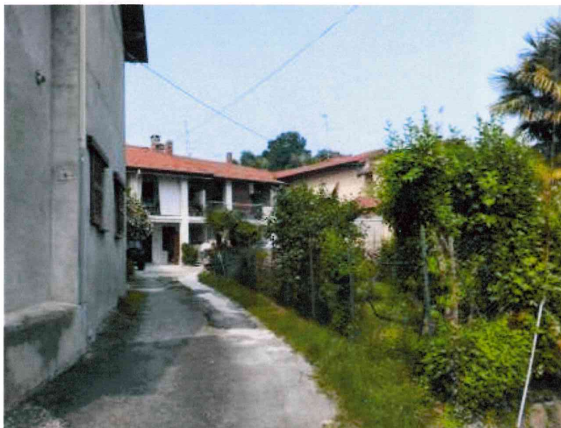
ACCESSO DALLA VIA MARCONI
