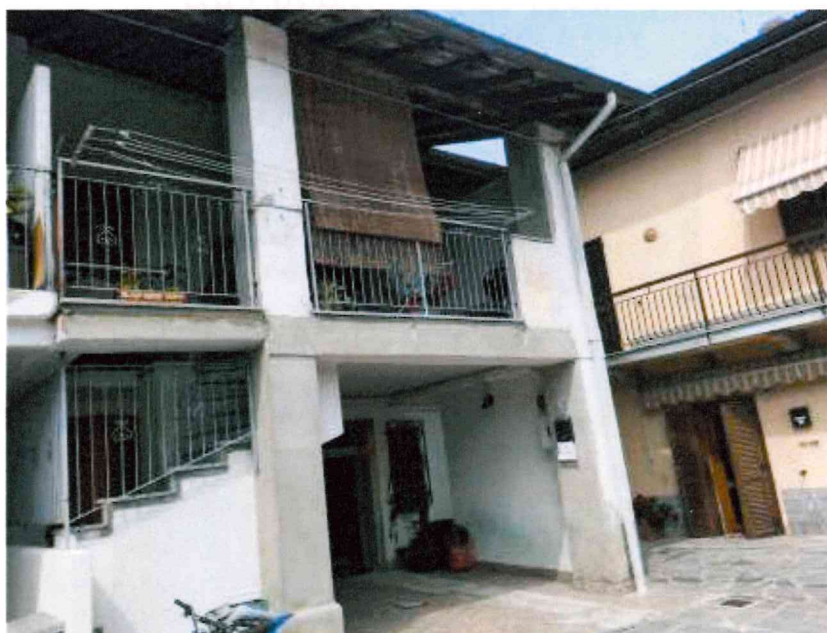
VISTA ESTERNA UNITA' IMMOBILIARE
