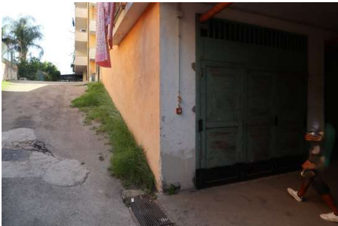
VISTA ESTERNA DEL BOX
