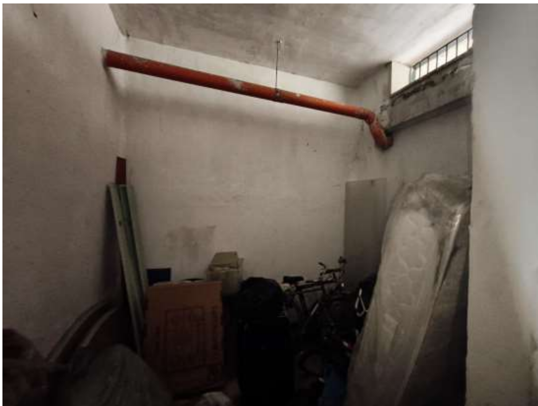
VISTA INTERNA DEL LOCALE DEPOSITO
