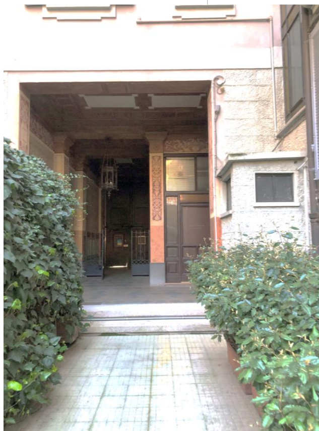
VISTE ANDRONE DAL CORTILE INTERNO
