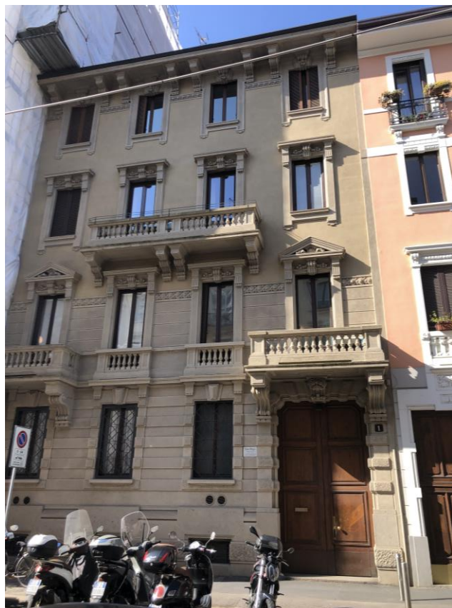
VISTA DEL FABBRICATO ESTERNO DA VIA PANIZZA
