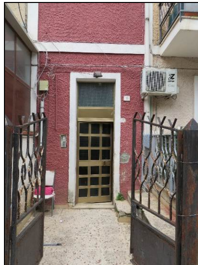
Portone di ingresso dell'edificio
