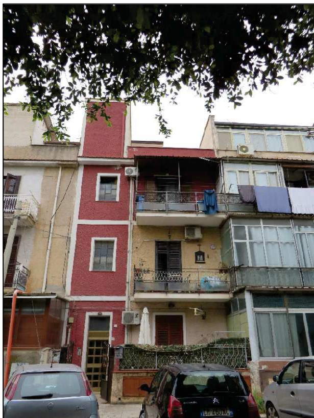
Edificio di via Pandora n. 10
