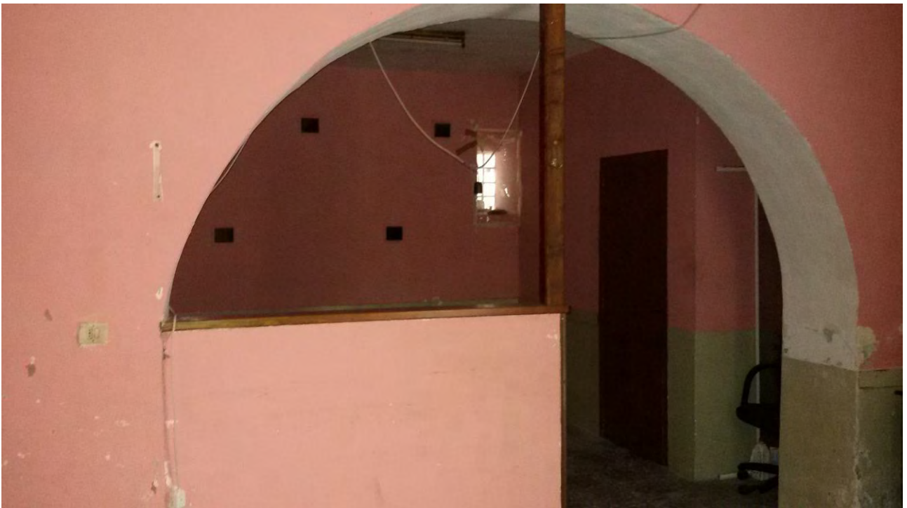
Immobile B sub2 foto 10
