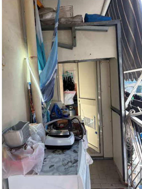
Foto n. 11: • Balcone pertinenziale (lato comunicante con poggiolo dell'immobile confinante facente parte della "scala B").
