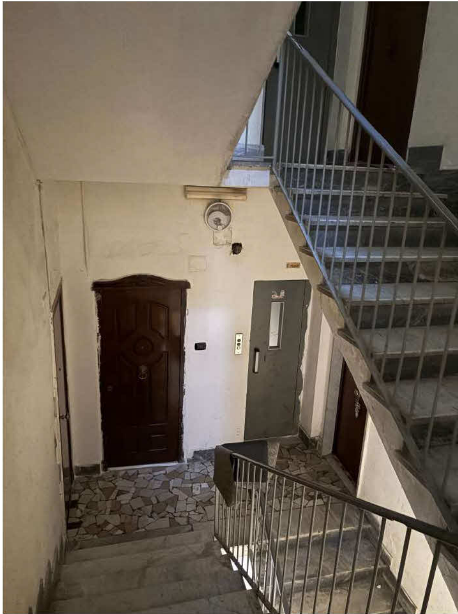
Foto n. 8: • Interni vano scala (particolare tipico).
