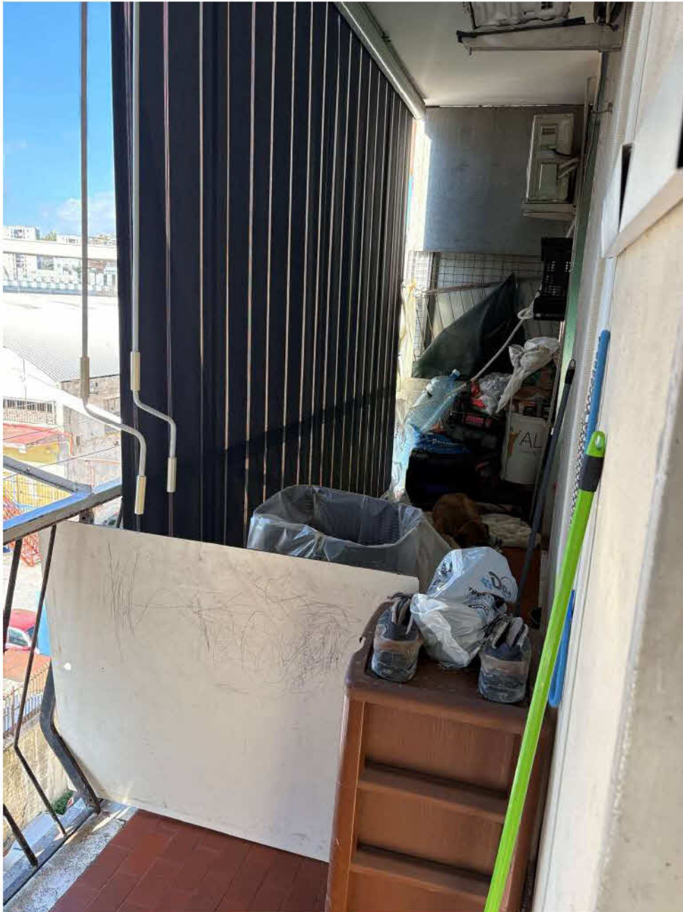
Foto n. 22: • Balcone pertinenziale (lato chiuso).
