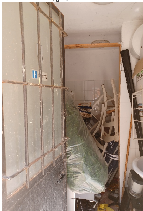
Immagine 24 - Bagno esterno usato come deposito
