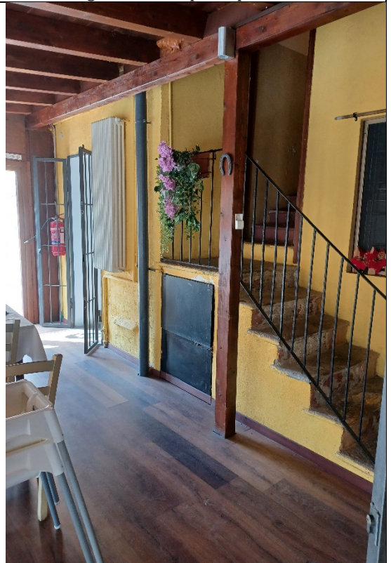
Immagine 8 - Vista della scala che conduce ad altra unità immobiliare, proprietà di terzi
