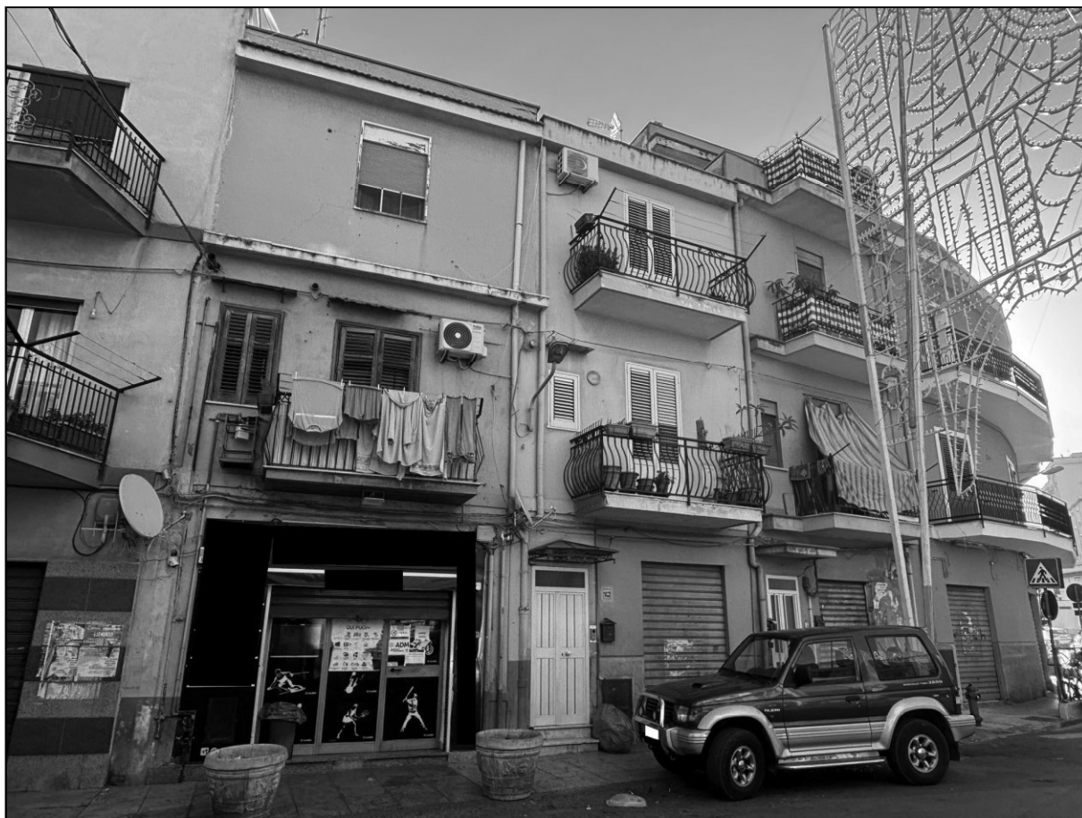
Foto 1 – Vista del prospetto su via Guadagna
