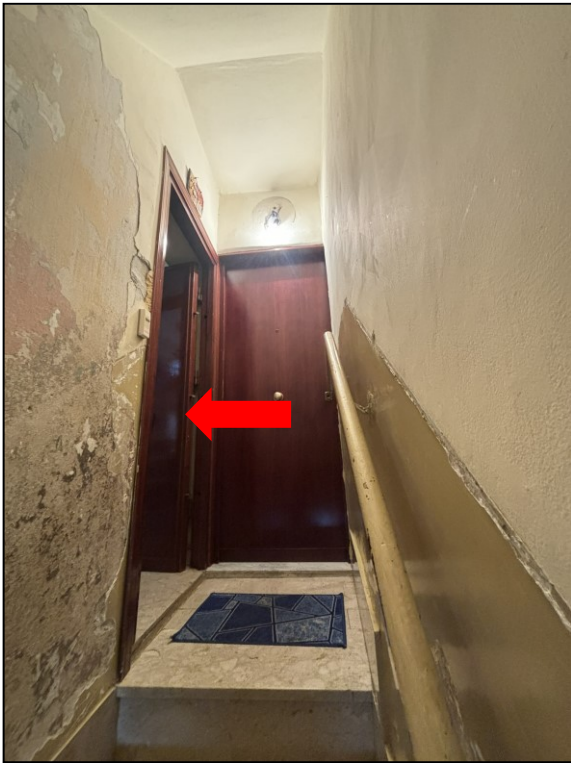
Foto 6 – Porta d'ingresso (piano 1°)
