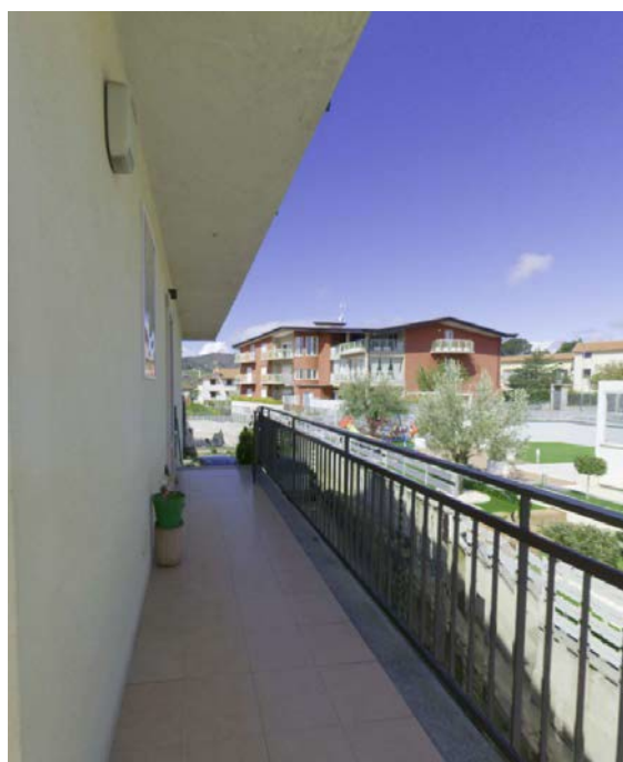
Balcone lato Est
