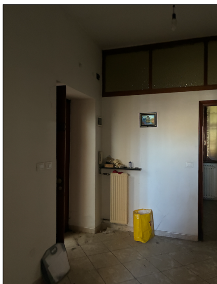
Vano di ingresso verso cucina
