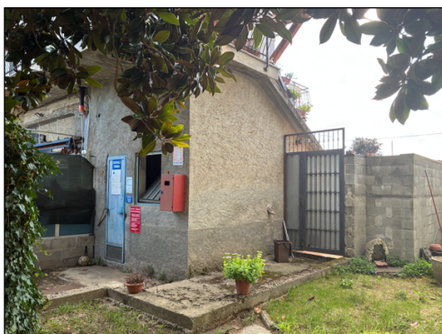
Vista da corte interna verso CT comune
