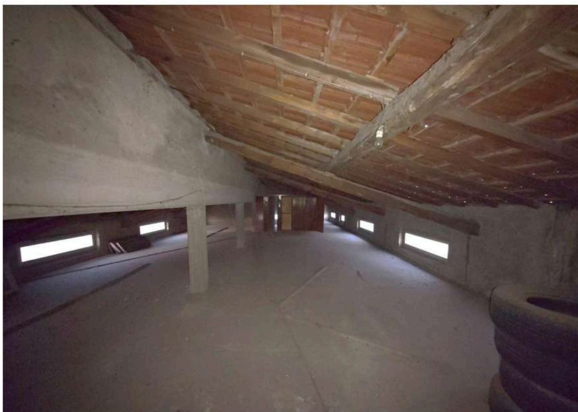
Veduta del sottotetto dell'apalazzina uffici
