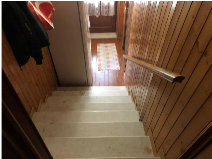
VANO SCALA INTERNO
