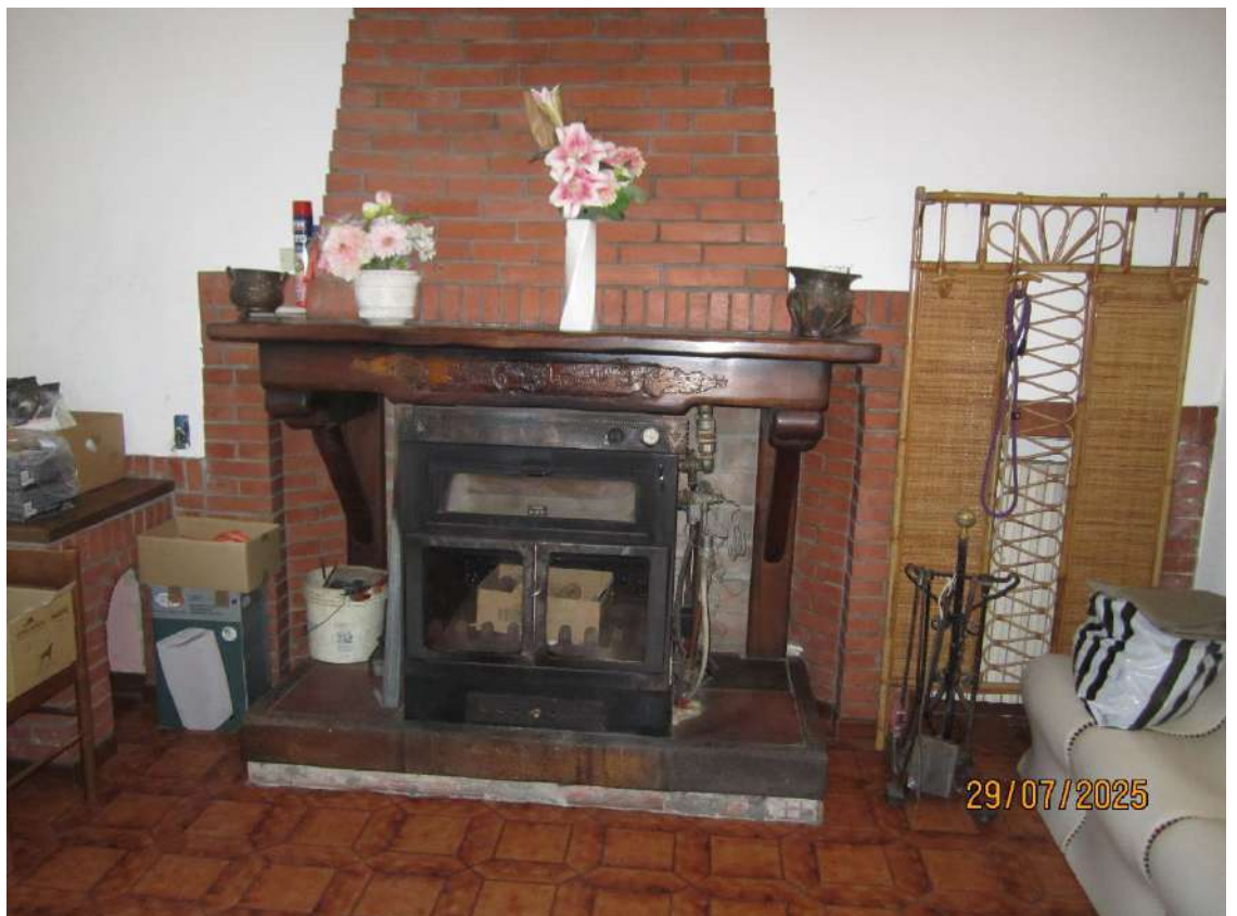
FOTO 10 Il termocamino nel soggiorno con funzione sostitutiva dell'originaria caldaia a legna.
