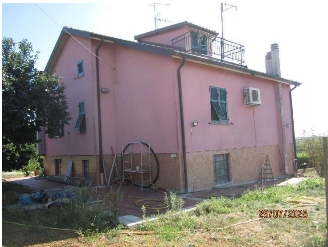
FOTO 6 Vista dall'angolo Nord-Est con la terrazza panoramica a livello copertura.
