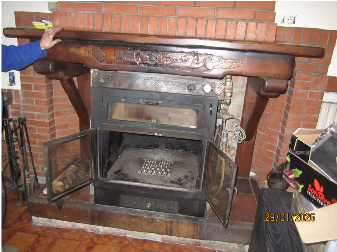
FOTO 1 – Il termocamino a legna inserito nel caminetto in muratura dell'ambiente soggiorno.
