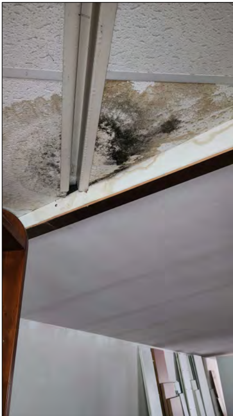
Particolare infiltrazioni/umidità
