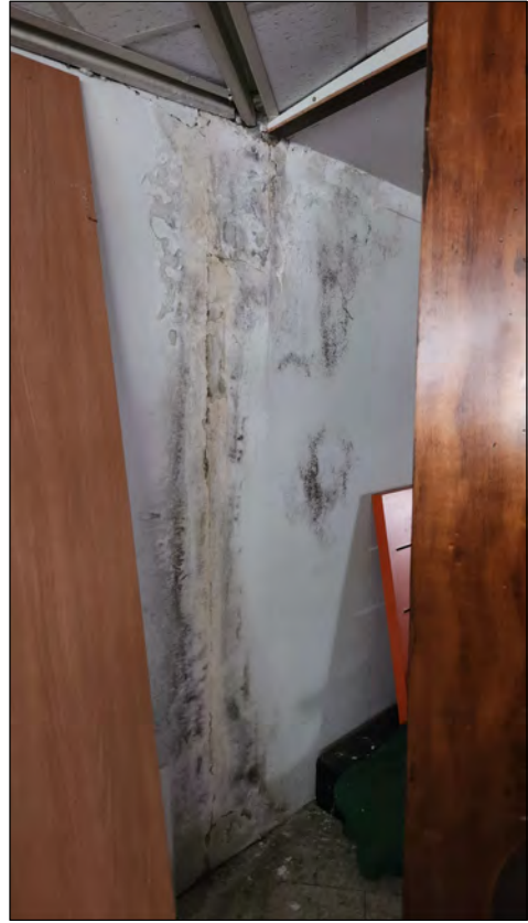
Particolare fessurazioni/umidità
