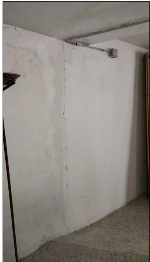
Particolare fessurazioni/umidità
