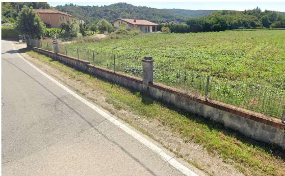
Figura 3 P.lla 1031 fascia stradale
