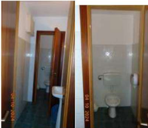
Foto n. 3 e 4 – Part. Antibagno e W.C.
