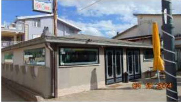
Foto n. 1 – Ingresso principale da area comune
