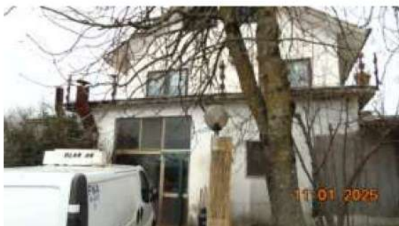
Foto n. 1 – Ingresso principale (disimpegno cucina)
