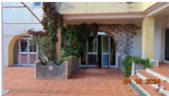
Foto n. 1 – Ingresso locale commerciale
