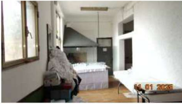
Foto n. 3 – Interno disimpegno (vista forno/deposito)
