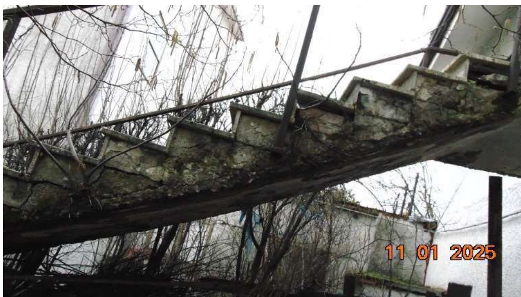
Lotto n. 3 - Foto 2 – Particolare scala di accesso
