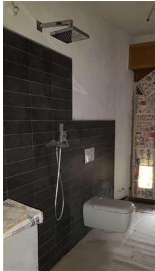
Vista del bagno al piano primo
