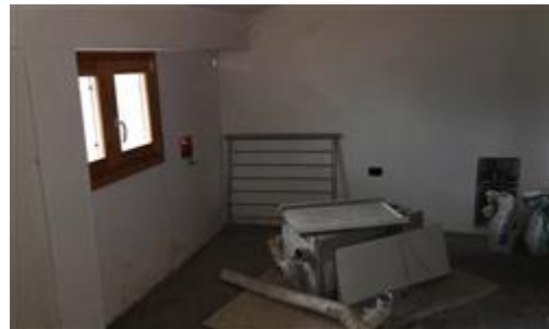
Vista del sottotetto 2
