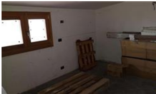
Vista del sottotetto 1
