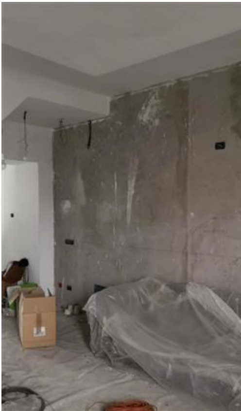
Vista interna al piano terra
