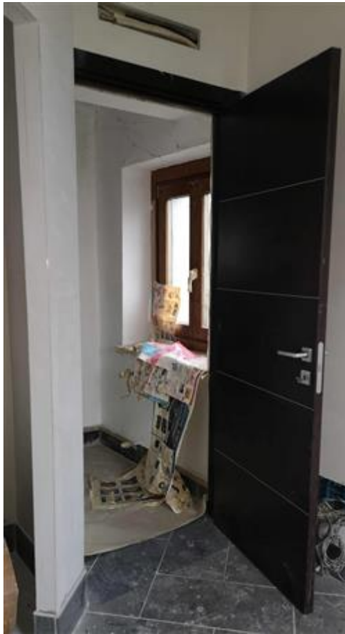
particolare porta al piano primo
