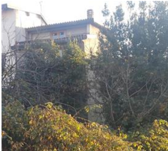
Vista d'insieme del fronte nord
