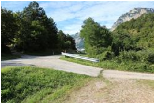
ACCESSO DA STRADA COMUNALE A SUD-OVEST
