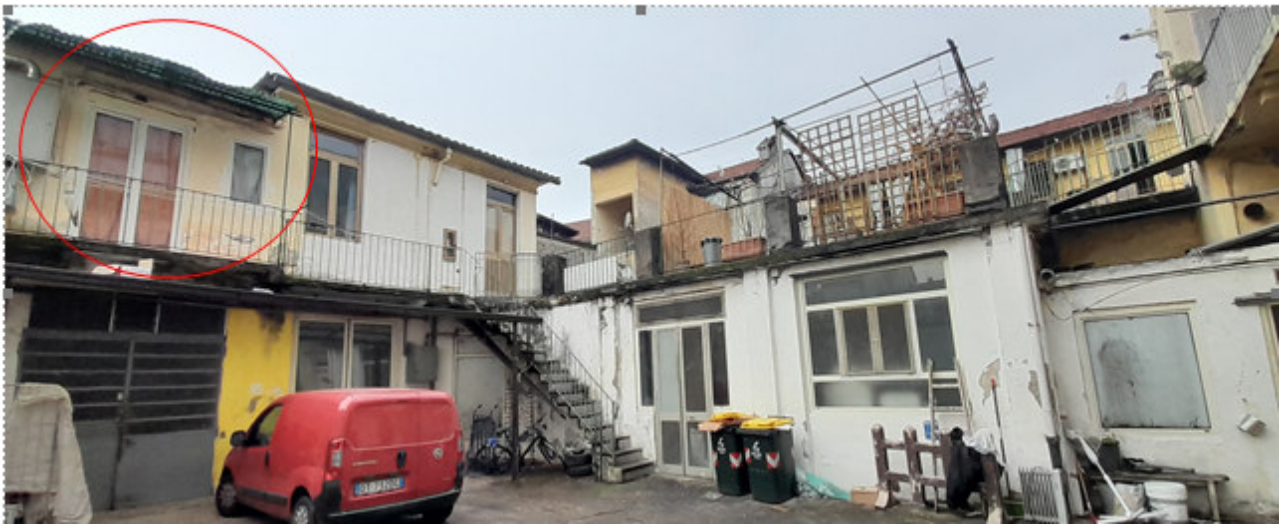
Foto 2 – Prospetto Fabbricato interno cortile
