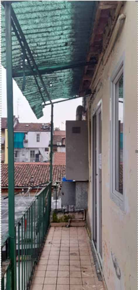
Foto 9 – vista ingresso ballatoio
